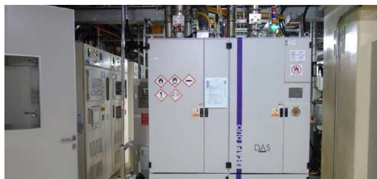
製程設備管末裝設削減設備 Local Scrubber
